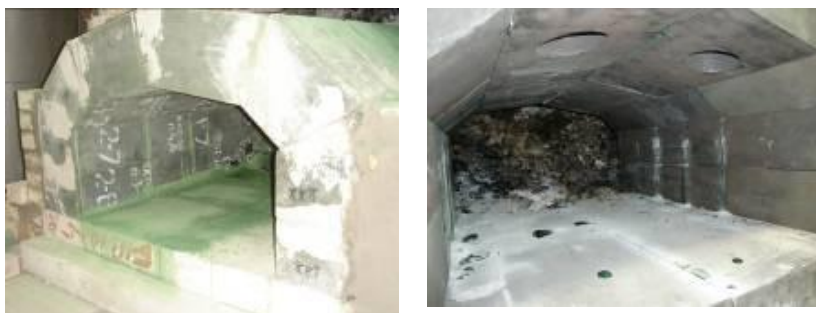
Рисунок 1 – Общий вид плавителя из крупногабаритных блоков
